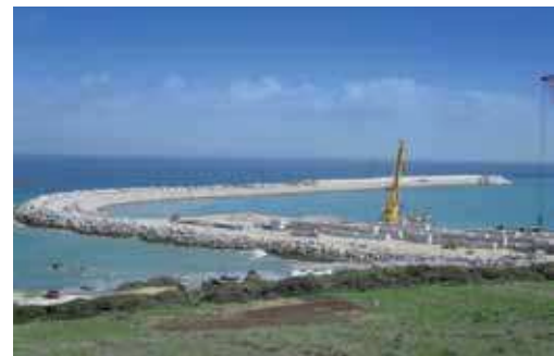
▲ Chantiers du port de Ksar Sghir.
