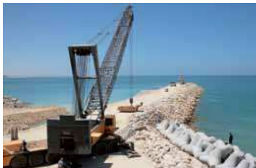
▲ Chantier de Boujdour.
