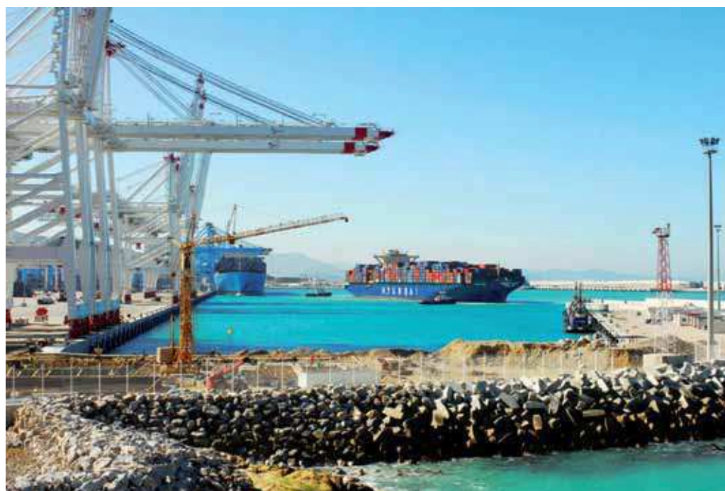
▲ Port de Tanger Med. Terminal à conteneur.
